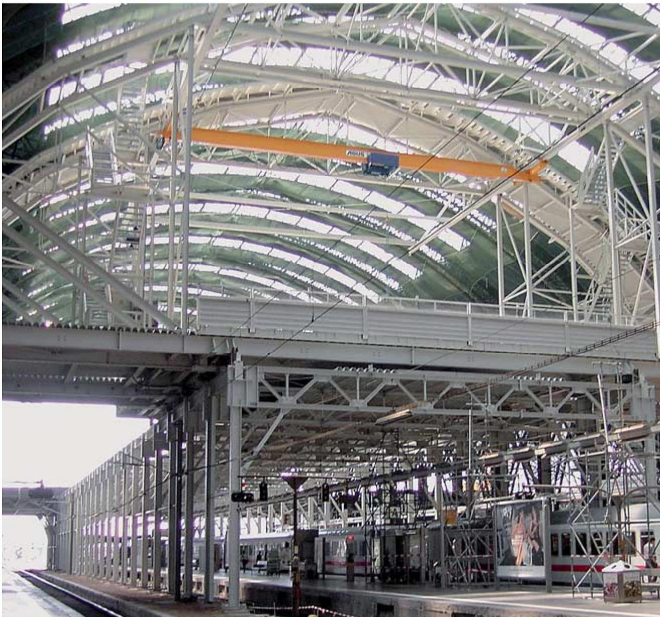
Las naves con estructura complicada precisan una solución especial que puede encontrarse fácilmente con los puentes grúa suspendidos de ABUS. El montaje de la viga carril bajo el techo en lugar de sobre pilares ofrece soluciones perfectas incluso bajo condiciones de sitio y arquitectura difíciles. Los puentes grúa suspendidos aprovechan al máximo el ancho de
